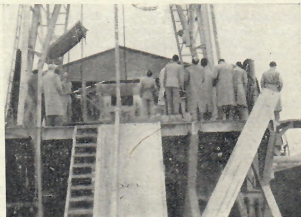
FIG. 1. - Cortemaggiore: Cambio di un tubo durante la trivellazione di un pozzo.
