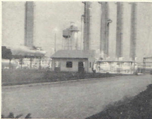
FIG. 2. - Cortemaggiore: Impianto di degasolinaggio.
