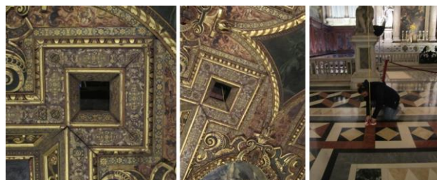
Figura 3. Rimozione del riquadro ligneo per collegare topograficamente la Sala e il sottotetto
