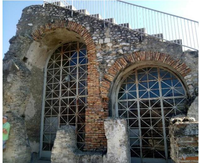
Figura 3. Esempio di discontinuità strutturale visibile in cui la volta a botte è costruita in parte in mattoni e in parte in muratura.
