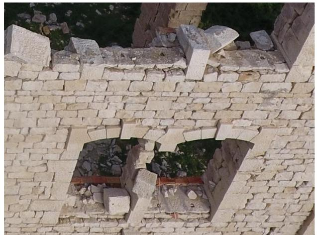
Figura 4. Esempio di manifestazione di degrado in un'apertura della Fornace Penna (RG).
