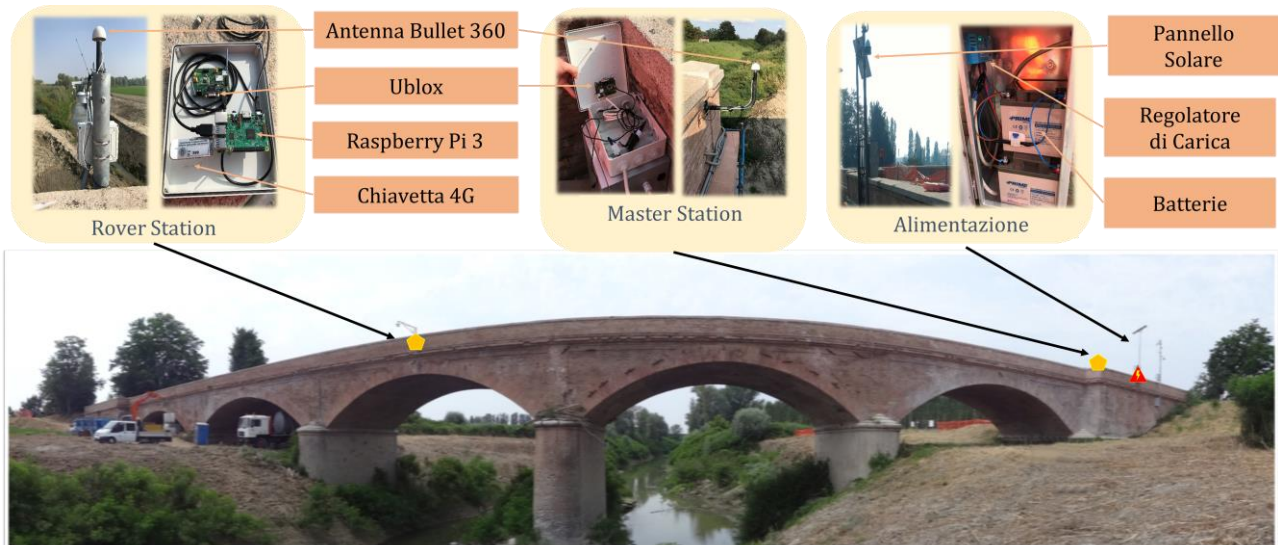
Figura 2. Il sito test (Ponte Motta di Cavezzo – MO) con collocazione dei sensori
