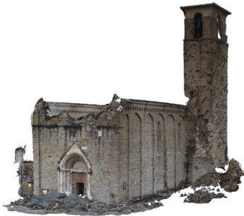
Figura 3. Modello tridimensionale texturizzato della Chiesa di Sant'Agostino ad Amatrice ottenuto con le immagini acquisite da fotocamera DSLR.
