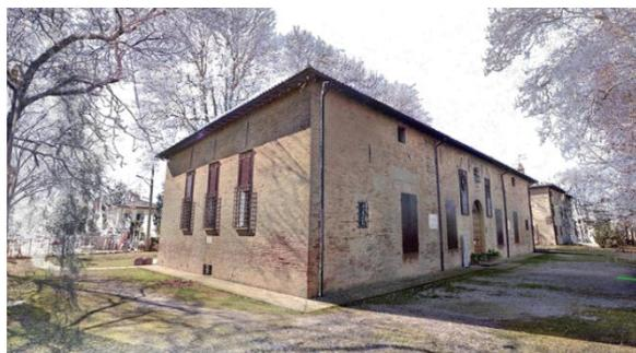
Figura 6. Vista esterna del modello tridimensionale a nuvola di punti del Mauriziano.
