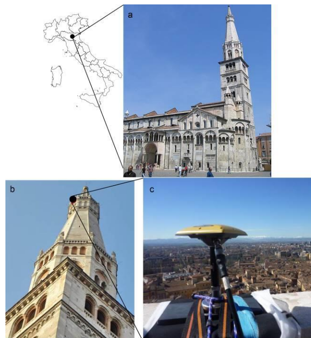
Figura 1. a) Torre Ghirlandina e Duomo, Modena (Italia), inclusi nella lista del patrimonio dell'UNESCO dal 1997. b) particolare della cuspide ottagonale e della sommità della Torre. c) Antenna GNSS installa sulla balaustra del ballatoio più alto della Torre a 78 m di altezza.
