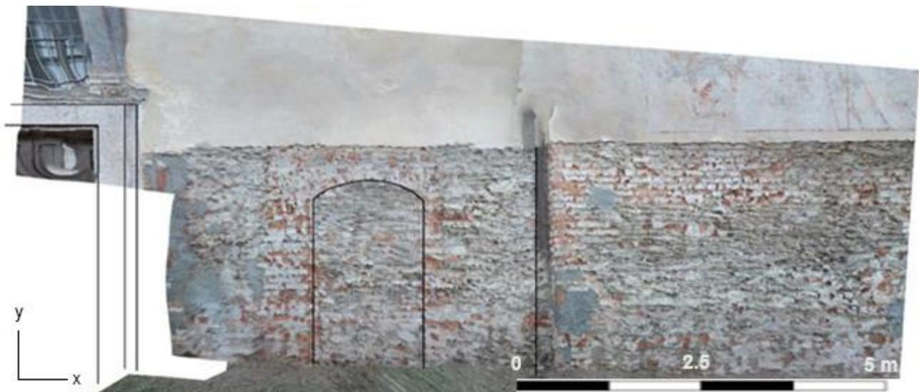
Figura 10 - Facciata 1b. Ortofoto estratta da PS, con bozza di restituzione delle linee principali.
