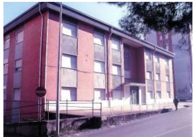
Figura 9. Fabbricato in esame e muro di sostegno
